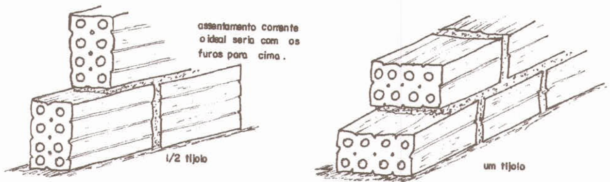
Figura 1 - Execução de alvenaria utilizando tijolos furados.
