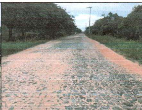
SENTIDO SEDE / LAGOA GRANDE - FOTO 4
