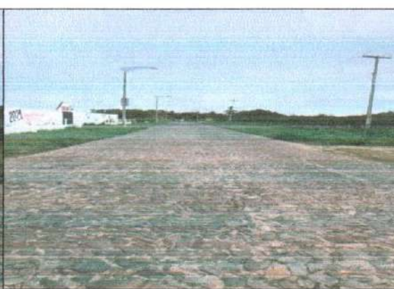
SENTIDO SEDE / LAGOA GRANDE - FOTO 6
