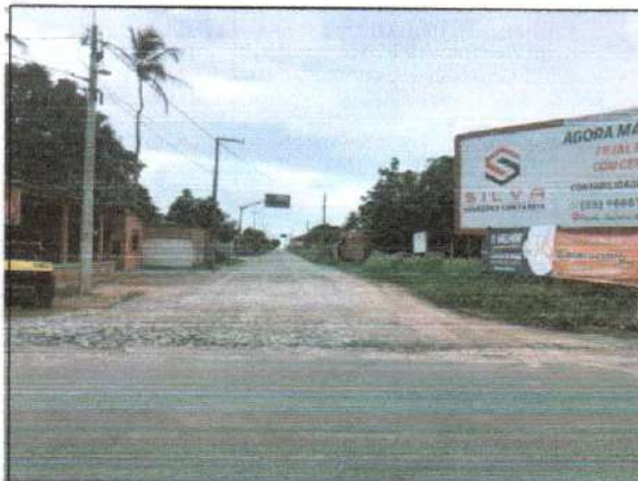
SENTIDO SEDE / LAGOA GRANDE - FOTO 1
